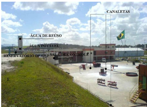
Figura 8 – Centro de Treinamento de Combate a Incêndios (Sampling Planejamento SA)
