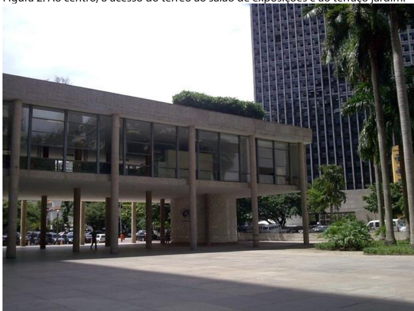
Figura 2: Ao centro, o acesso do térreo ao salão de exposições e ao terraço jardim.
