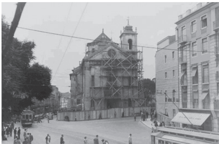
Antiga Igreja de Nossa Senhora do Socorro (Mouraria, Lisboa), demolida em 1949.
