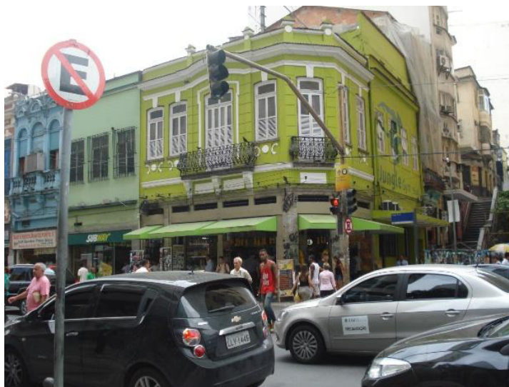
Figura 2: em dezembro de 2014, o imóvel foi pintado, recebeu toldos e houve a retirada de tabuletas da fachada.
