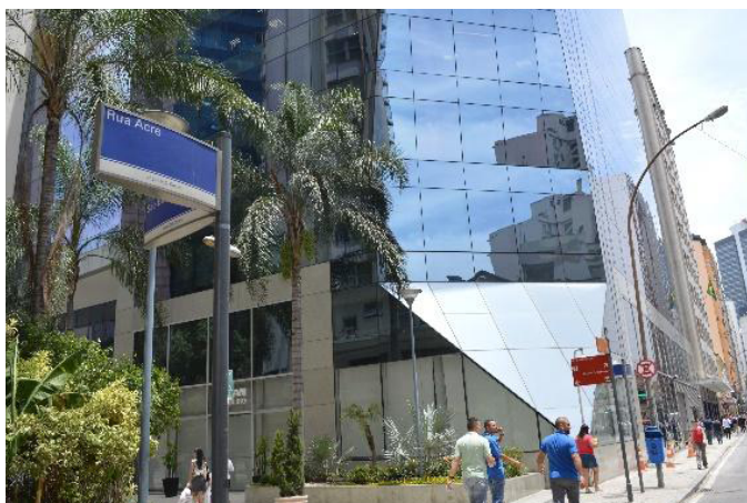
Figura 10: em dezembro de 2014, edifício inaugurado e ocupado por escritórios.
