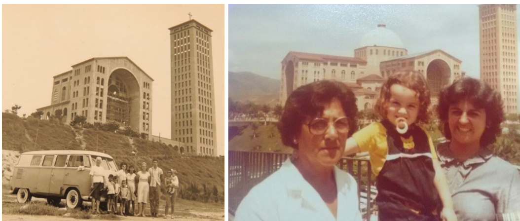
Figura 10. Fotografias familiares em frente às obras da basílica nos anos 1960 e 1980, respectivamente
