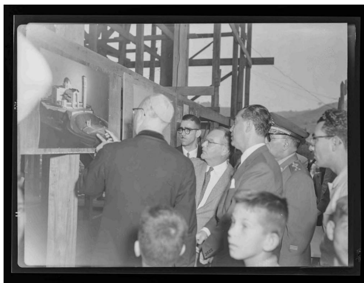
Figura 8. No canteiro de obras da futura basílica, Calixto Neto e Cardeal Motta apresentam imagem da maquete ao Presidente Kubitschek
