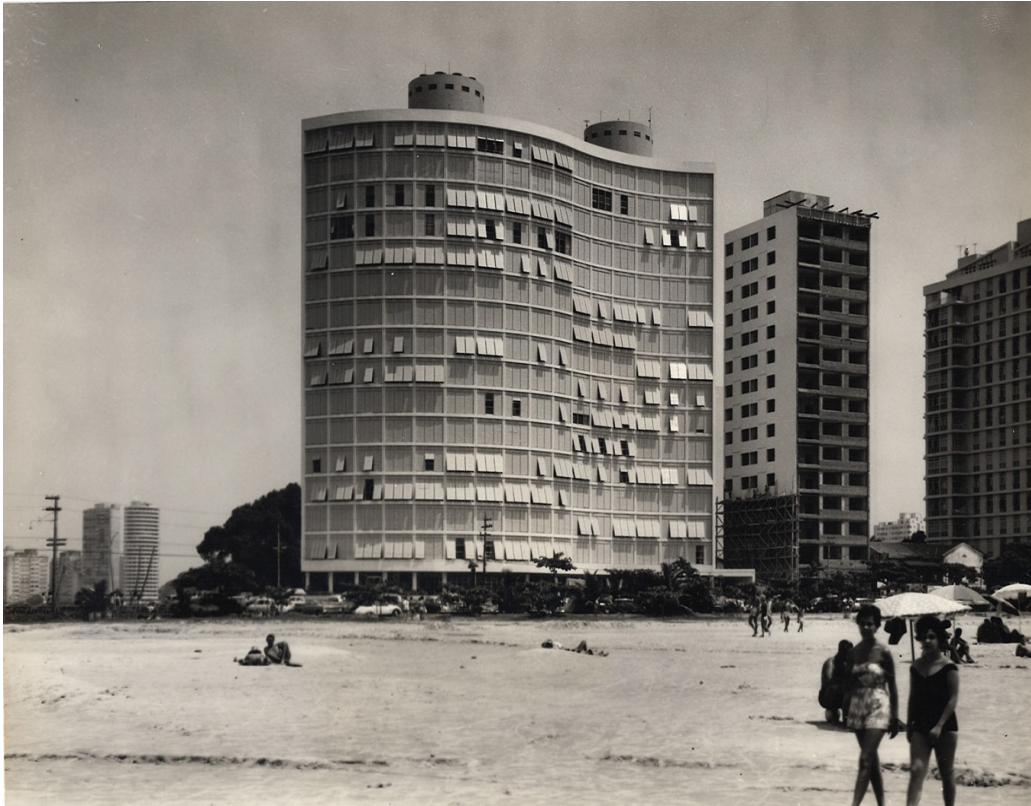
Edifícios Marahú, Tendai (em construção) e Mainumbi, 1961.
