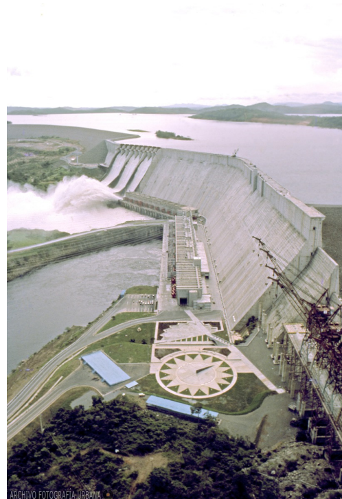
Fig 6 - Central Hidroelétrica Simón Bolívar (antiga Raúl Leoni). Da esquerda para a direita, reservatório, vertedouro, barragem, Plaza del Sol y la Luna e construção da extensão da parede da barragem. Represa del Guri, Estado de Bolívar, c. 1978. Foto: Fernando Irazábal © Archivo Fotografía Urbana.
