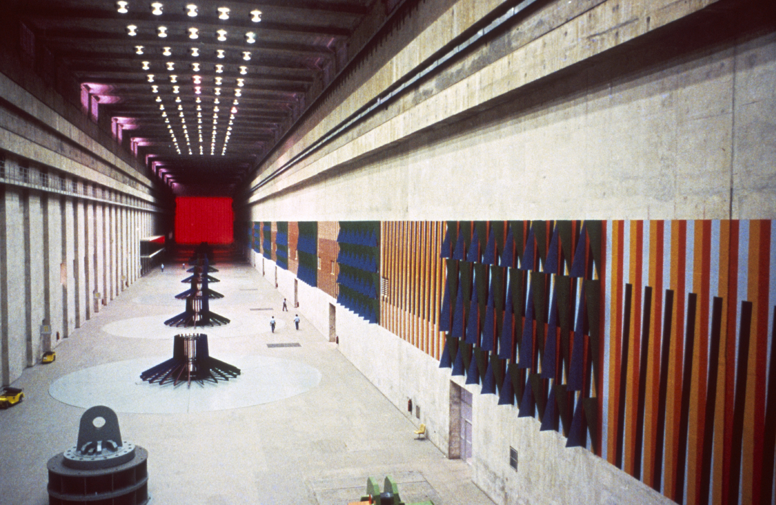
Fig. 8 - Carlos Cruz Diez, Ambientación cromática (Chromatic Environment) , 1977-1986. Estación Hidrelétrica Simón Bolívar, Sala de Máquinas nº 1, Guri, Venezuela. 28 x 300 x 26 m. Engenheiros: H. Roo, A. Gamboa, E. Carrera, G. Chavarri. © Adagp, Paris 2017.
