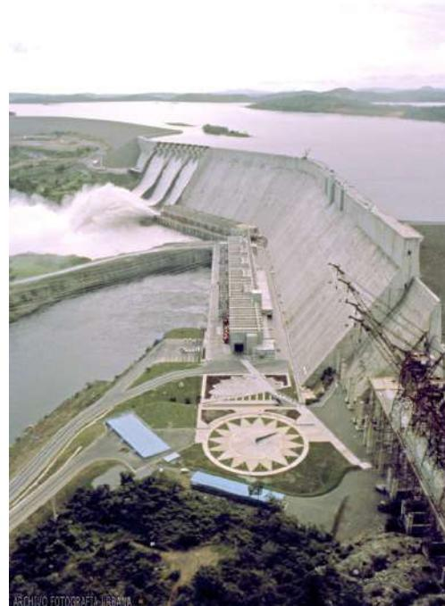
Fig 6 - Central Hidroelétrica Simón Bolívar (antiga Raúl Leoni). Da esquerda para a direita, reservatório, vertedouro, barragem, Plaza del Sol y la Luna e construção da extensão da parede da barragem. Represa del Guri, Estado de Bolívar, c. 1978. Foto: Fernando Irazábal © Archivo Fotografía Urbana.
