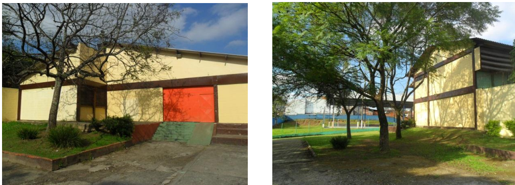
Figura 1: Fotos da fachada e da lateral da Escola.
