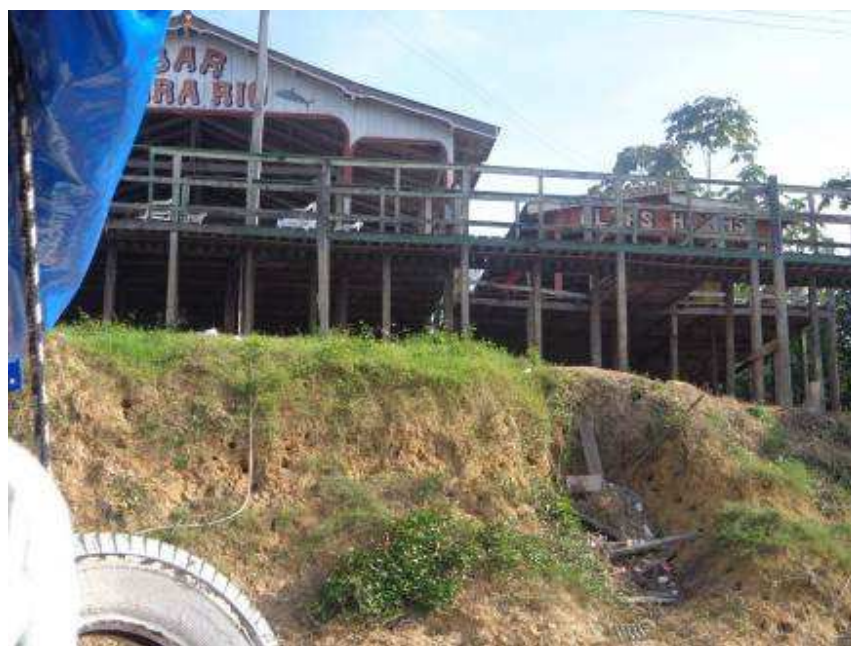
Vista de dois Bregas mostrando a estrutura que os defende durante a cheia. Foto de Eduardo Castelo Branco e Silva
