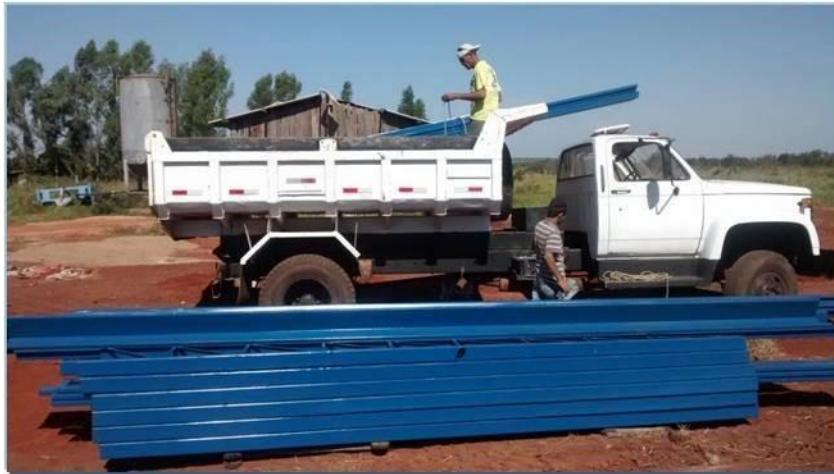
Figura 3: Construção do Centro Comunitário do Assentamento São Joaquim, em Selvíria/MS
