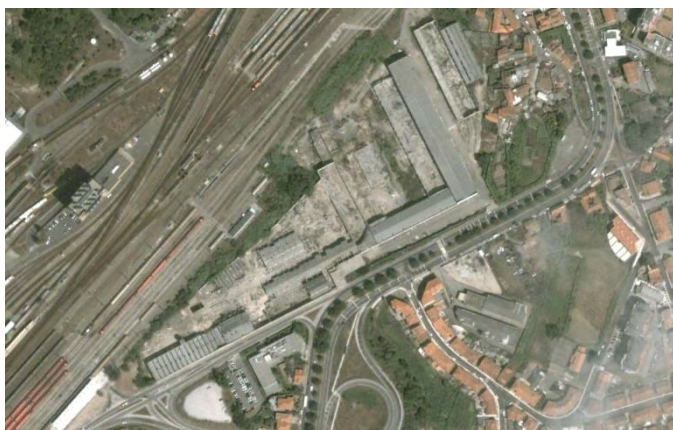
Fig. 17 – Perspectiva aérea sobre as instalações da CPC em 2003, parcialmente demolidas. 40
