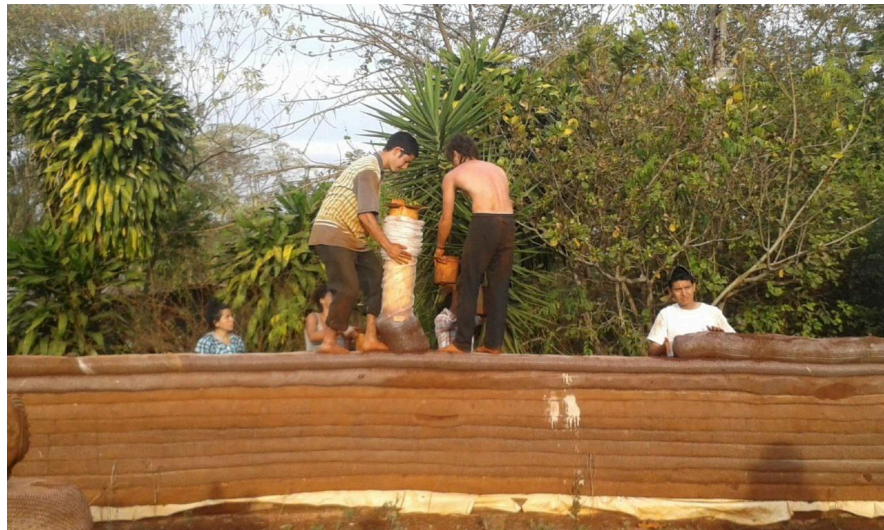
Figura 5 – Oficinas de Bioconstrução, construção das paredes e divisões dos futuros cômodos.
