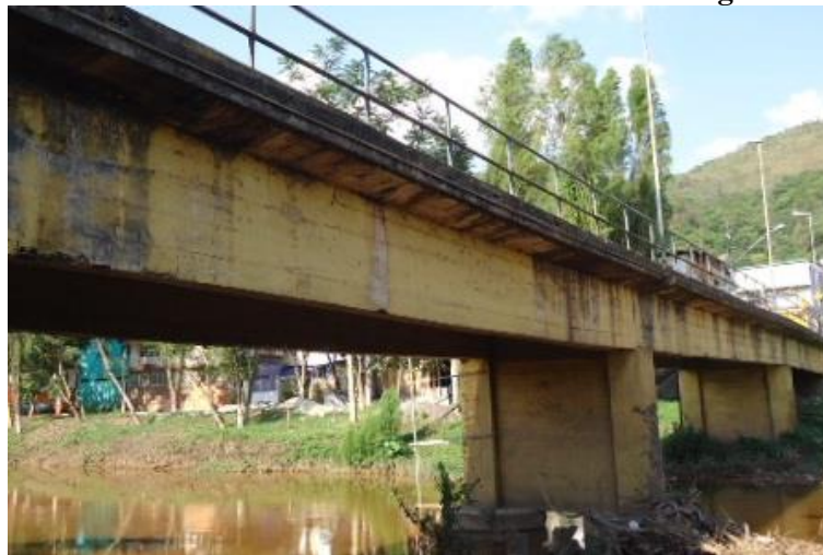
Figura 9 – Vista lateral direita da Ponte Governador Magalhães Pinto
