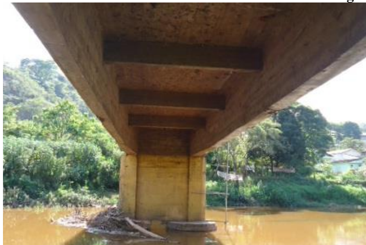
Figura 11 – Vista inferior do tabuleiro da Ponte Governador Magalhães Pinto
