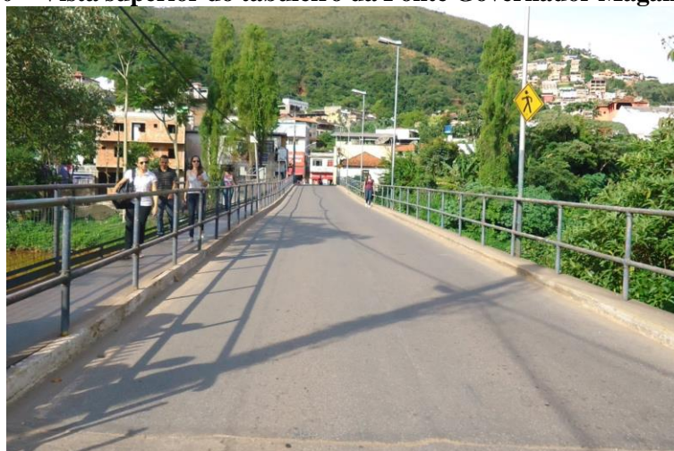
Figura 10 – Vista superior do tabuleiro da Ponte Governador Magalhães Pinto
