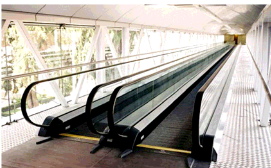
Figura 3 - Passarela na cidade de Curitiba, Paraná, Brasil
