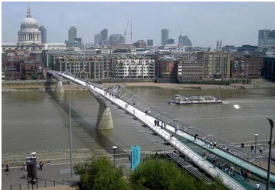
Figura 1 - Passarela sobre o Rio Tamisa em Londres
