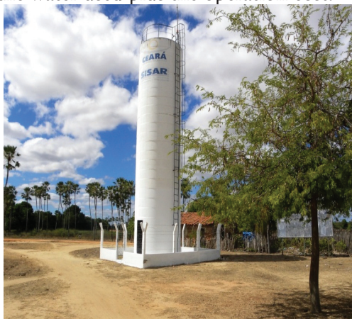
Figure 2 – Elevated Tank-Community of Córrego da Catita-Município Russas-CE
