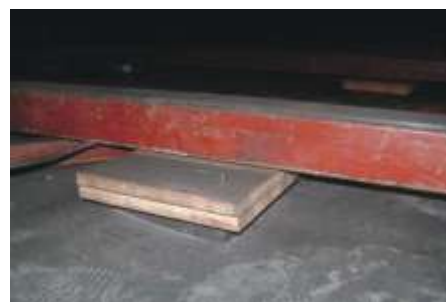
(c) Detalhe dos apoios.
