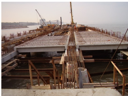
Figura 4 – Vigas pré-moldadas protendidas tipo \pi (montagem do cais) – TECON/RG.
