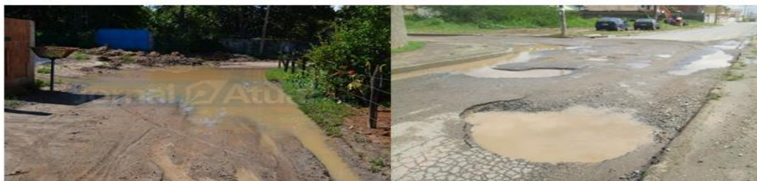
Falta de pavimentação. Bairros de Santa Cândida e Ibirapitanga. Fonte – Jornal Atual
