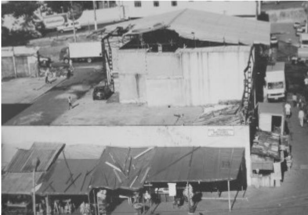
Figura 5: Barracas improvisadas na frente de antigo galpão destruído pelo incêndio
