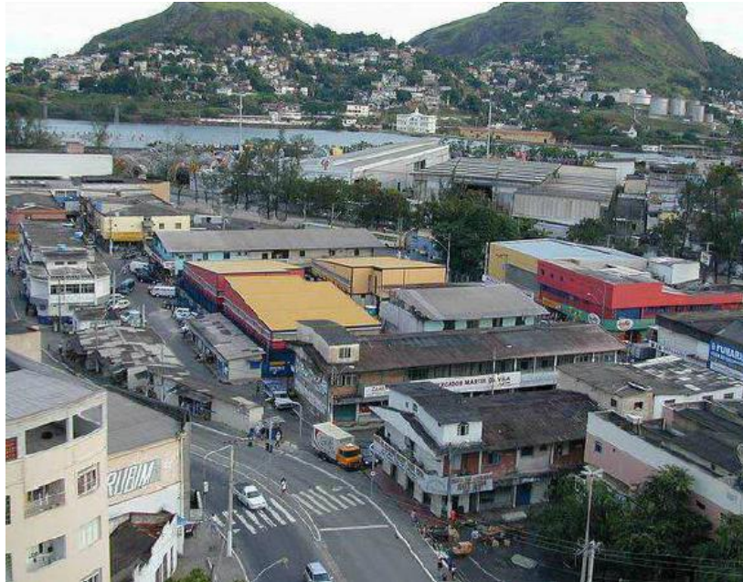
Figura 8: Galpões após a reconstrução.
