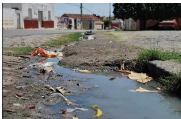
Figura 11 – Lançamento de esgoto doméstico no açude público José Teodoro (Açude velho)
