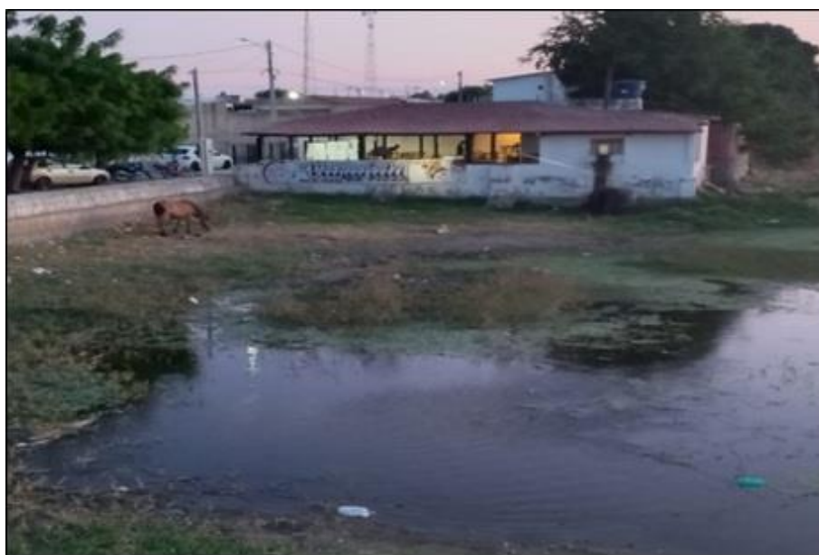
Figura 7 – Residência com risco de inundação localizada na APP do açude público.
