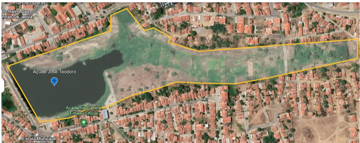
Figura 10 – Construções localizadas na APP do açude público José Teodoro (Açude velho)
