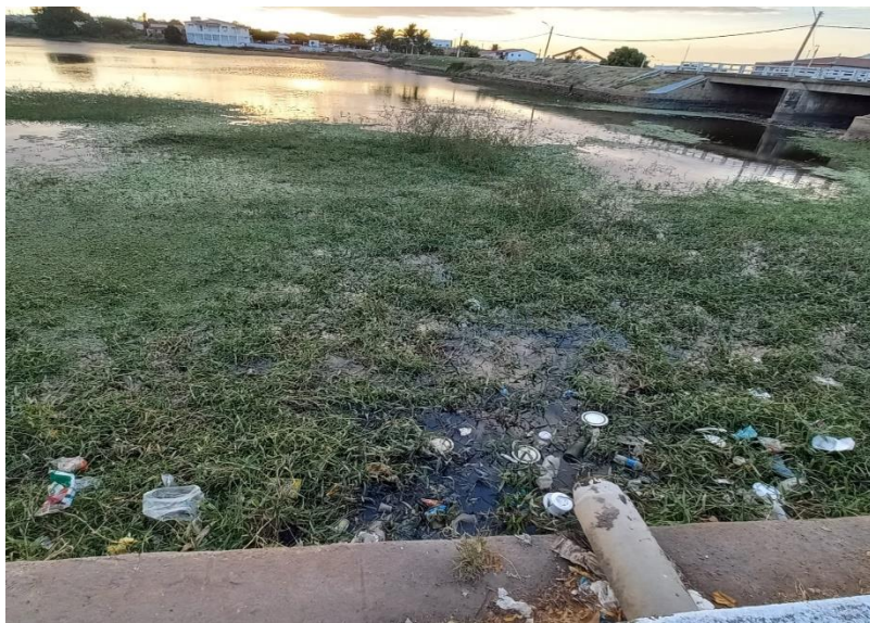
Figura 9 – Lançamento de efluentes domésticos no açude público José Teodoro.
