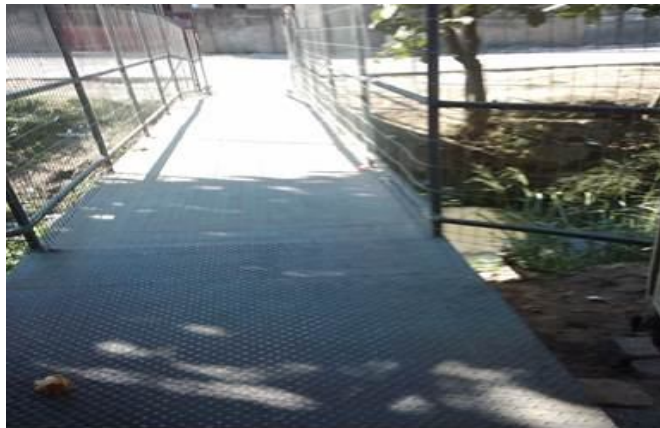
Foto 3 - Ponte que liga a rua à entrada principal da E.M. Afonso Salles.
