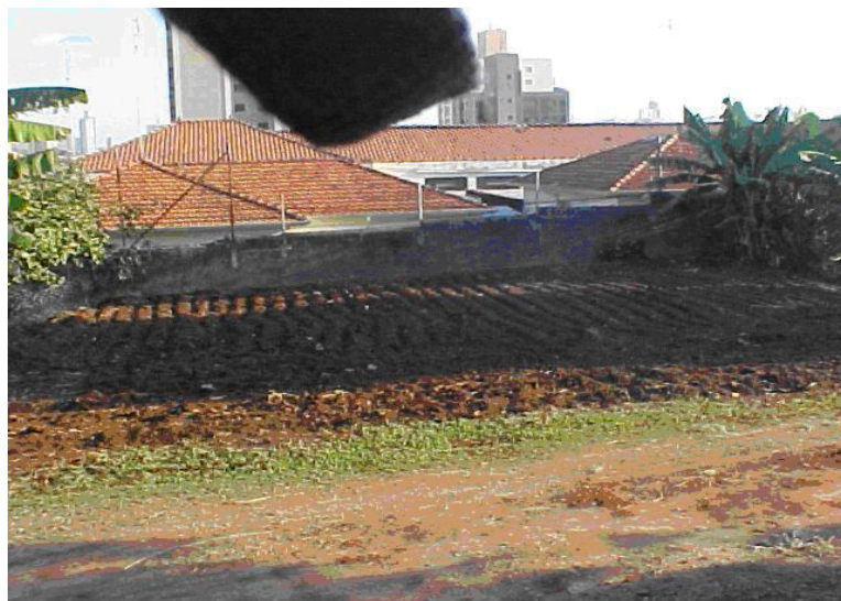
Foto 2 - Nivelamento para a construção dos canteiros
