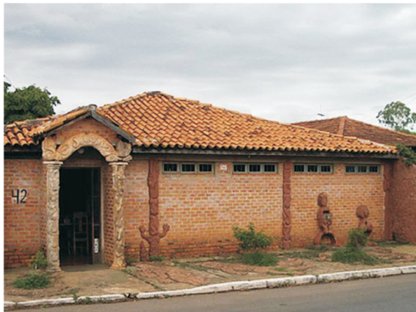
Fig. 12. Casa Basaia – Fachada.
