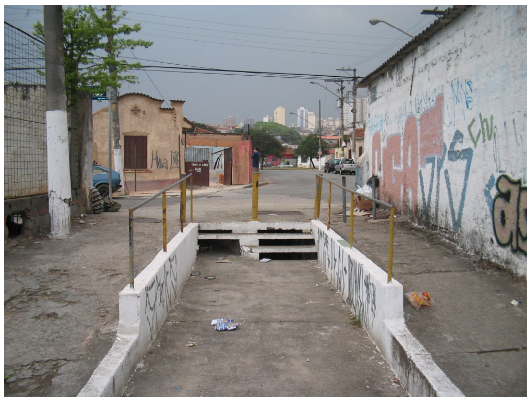
Figura 2 – Degraus associados a um bueiro denunciam o córrego Água Preta. Fonte: Foto do autor.
