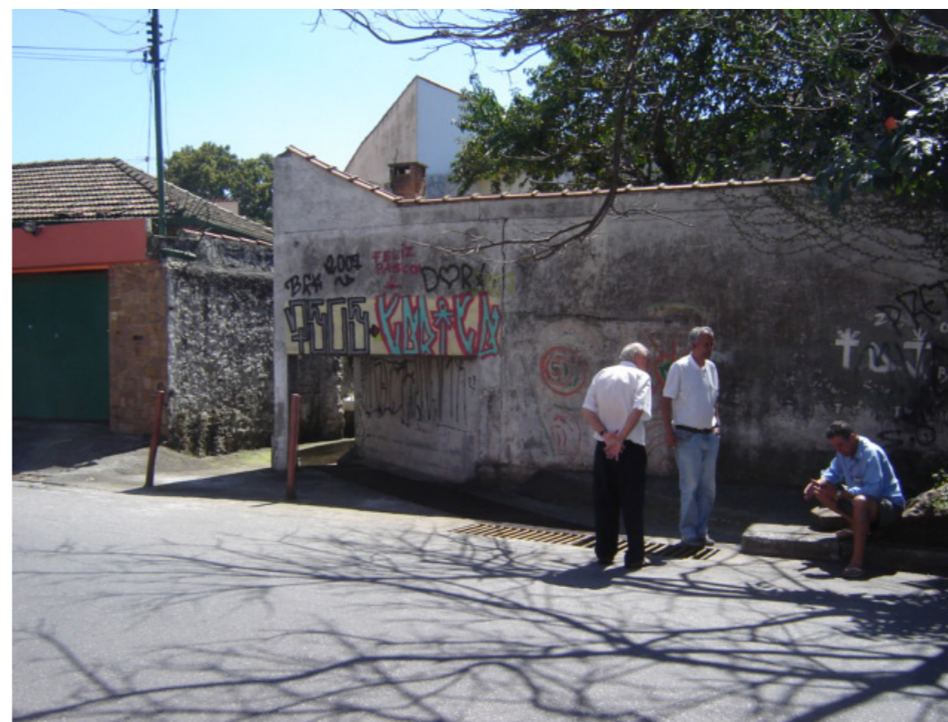
Figura 3 – Laje de construção particular projeta-se sobre o caminho do córrego Água Preta. Fonte: Foto do autor.
