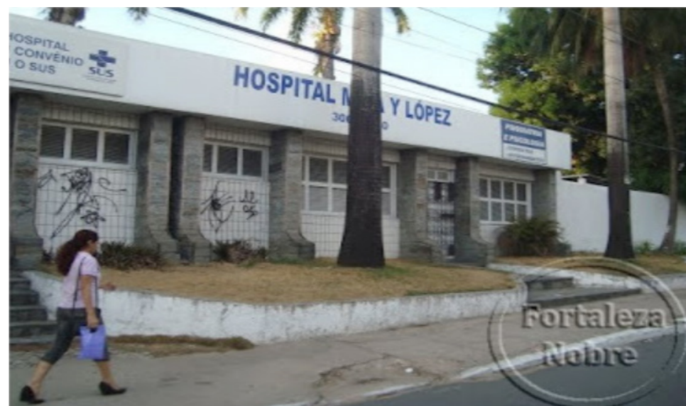
Figura 08 – Antiga fachada do Hospital Mira Y López. Fonte: Evangelista (NOBRE, 2013).
