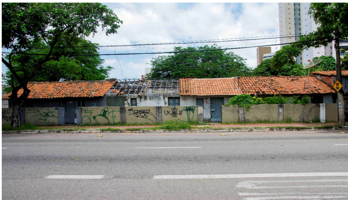
Figura 05 – Setor da Vila em processo de demolição.
