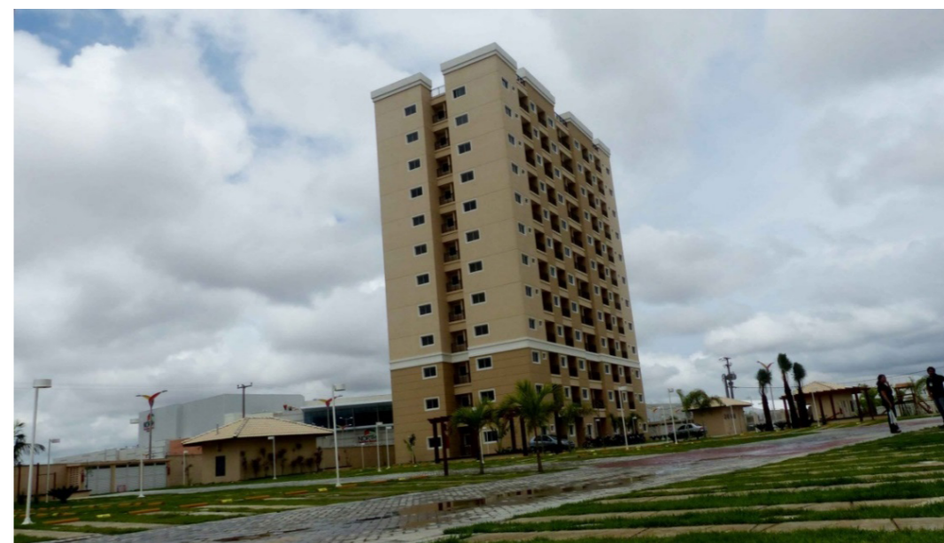
Figura 14 – Um dos edifícios do Residencial Jockey Ville. Fonte: R. F. Aragão, 2016.
