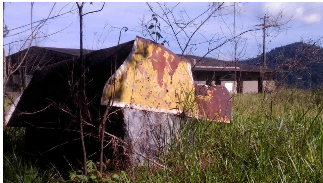
Figura 5 – Equipamento abandonado na pista de esqui com lanchonete ao fundo em ruína, Petrópolis, RJ
