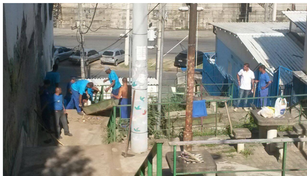
Figura 1 – Rua Icaraí, em setembro de 2014. De um monturo de lixo a uma sequência de platôs com espaços livres de passagem, lugares de encontro e brinquedo, declives com jardins e horta, no que designamos “Jardim da Tia Neuma”. Aqui o momento final do processo de limpeza da rua com apoio da Companhia Comunitária de Limpeza
