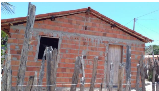
Figura 06 - Moradia de alvenaria após a PNHR
