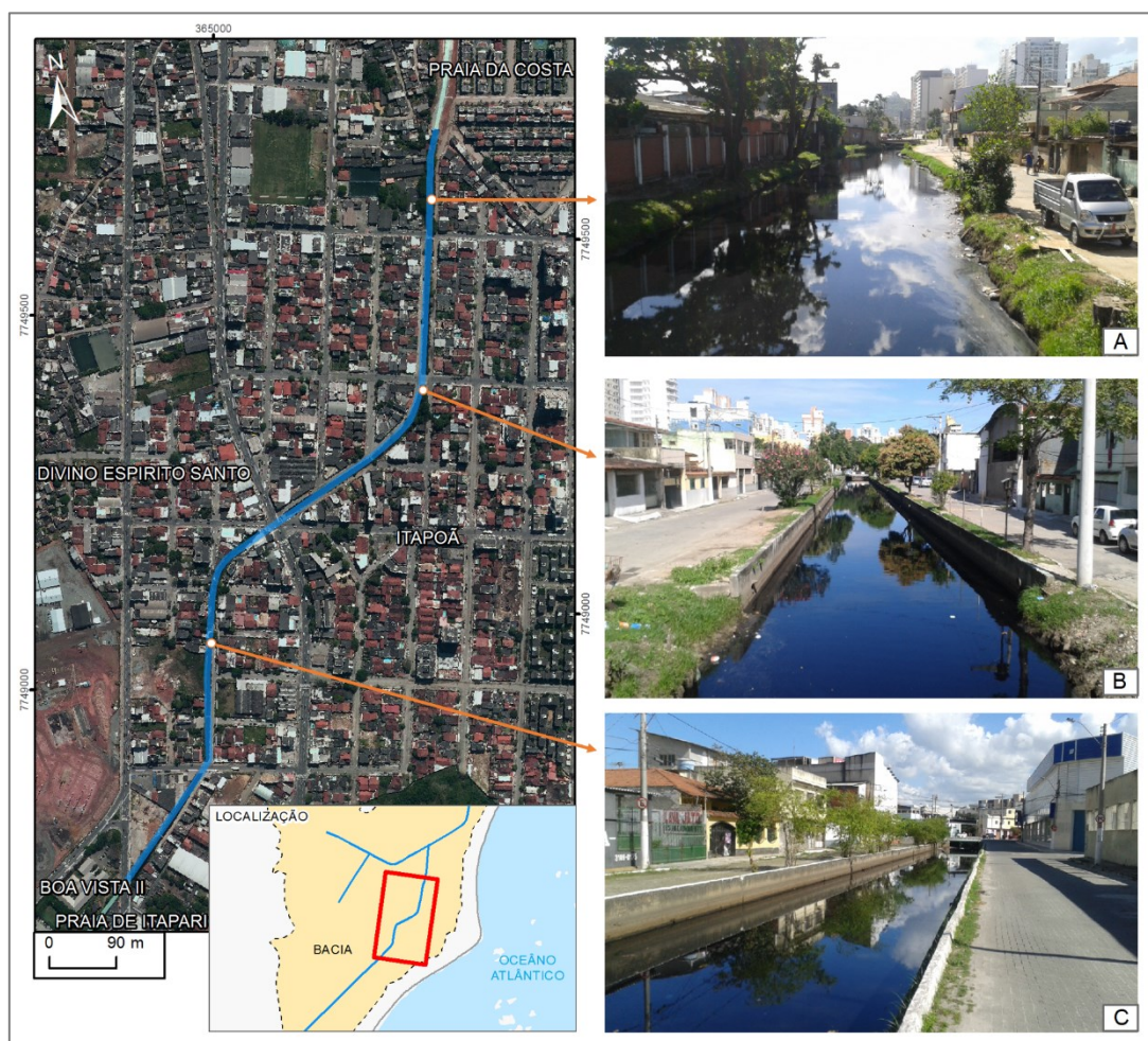
Figura 6 - Trecho do canal da Costa com suas margens canalizadas
