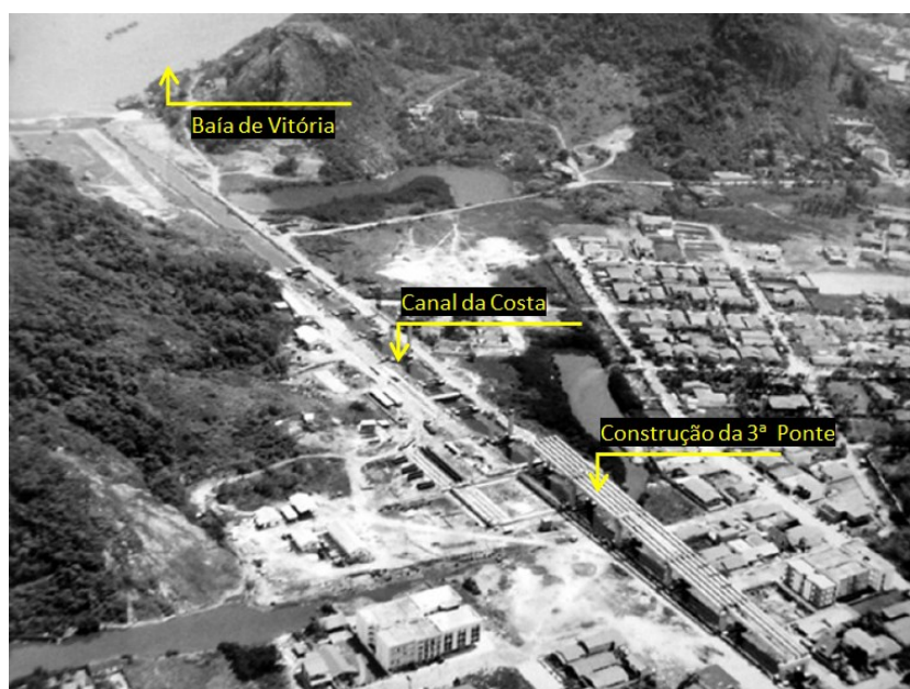
Figura 4 - Fotografia da foz do Canal da Costa e início da construção da Terceira Ponte
