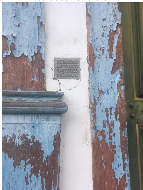
Figura 3 - Placa indicando “Patrimônio Histórico e Artístico Nacional” na fachada de uma edificação no centro de Diamantina
