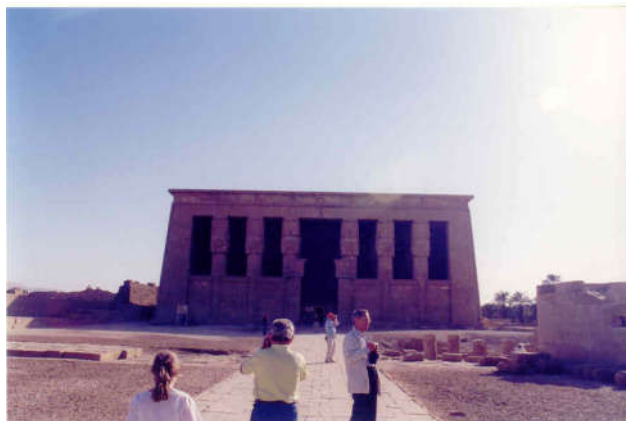
Figura 04 - Fachada do Pronaos do Templo de Hathor em Dendera. O pilone e o pátio externo não existem mais. O que pode ser visto é sala hipóstila (o pronaos) cuja construção é característica deste período. Fonte: foto de GRALHA, 2007.
