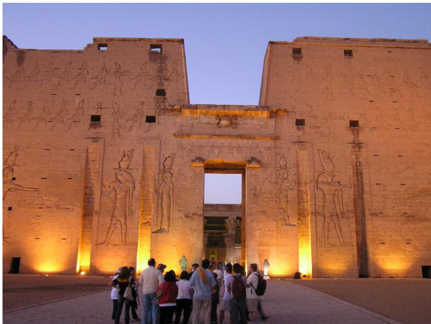
Figura 01 - Fachada templo de Hórus em Edfu.
