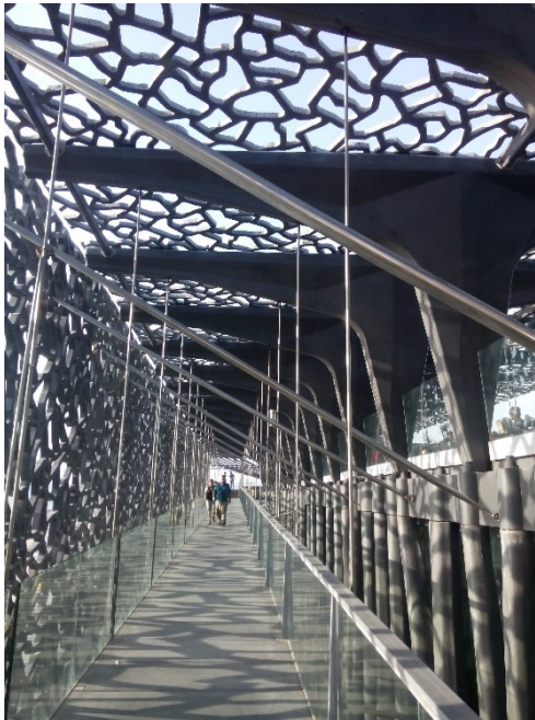
Fig. 8a e 8b - A torre CMA-CGM vista do teto-malha do museu e as várias camadas estruturais do MUCEM. (Fonte: Arquivo pessoal da autora; Foto: Cécile Bourgade)
