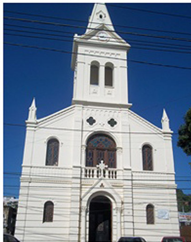
Bem tombado municipal Igreja Nossa Senhora de Fátima - Imóvel situado na Rua Barão de Mauá, 274 – Ponta d'Areia – Niterói – RJ.
