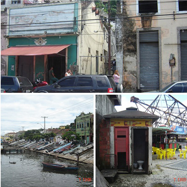
Abandono, descaracterização e deterioração da área.
