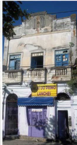
Casarios abandonados nas ruas do entorno a Praça Leoni Ramos.
