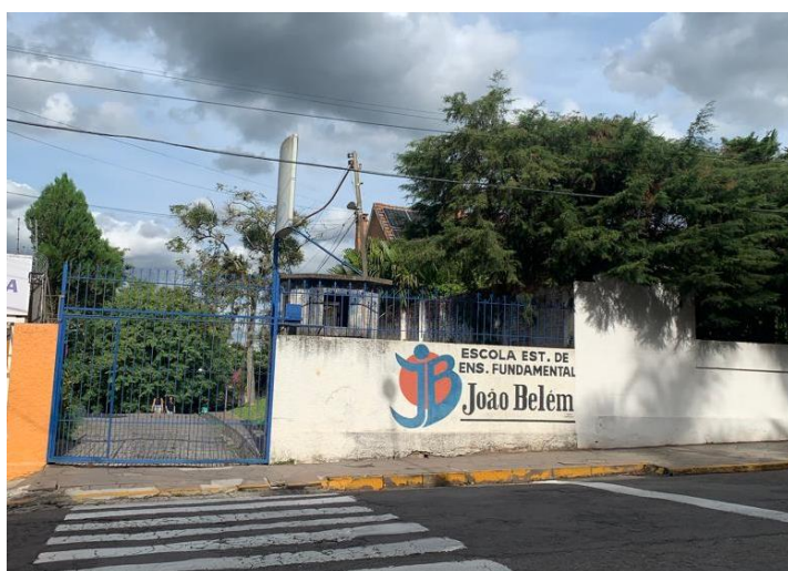
Figura 2. Fachada da escola
