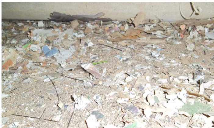
Figura 1: Detritos sobre o forro do telhado da escola pública, Duas Barras, RJ, 2014.
