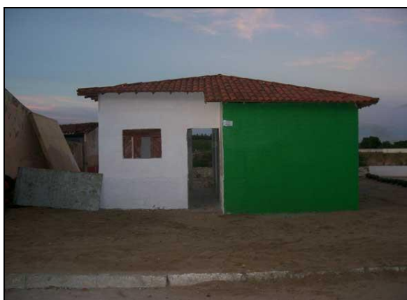
Figura 4: Etapas da Construção das Casas Populares com Garrafas PET Fonte: Portal Met@lica (2010).
