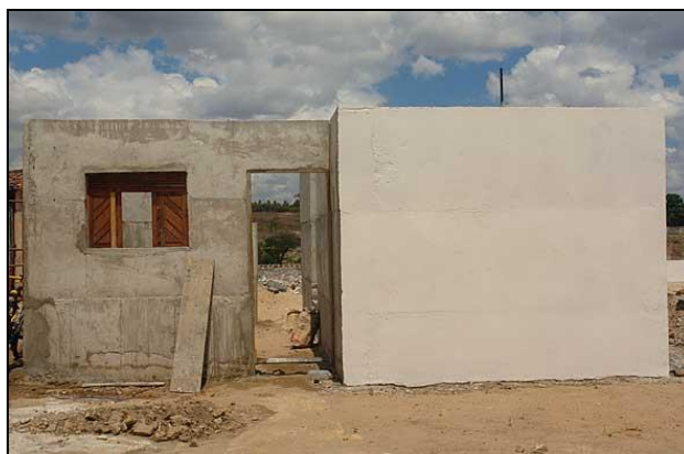
Figura 3: Etapas da Construção das Casas Populares com Garrafas PET Fonte: Portal Met@lica (2010).
