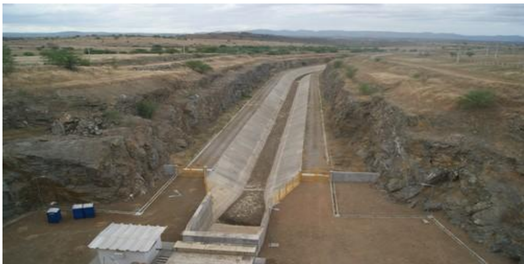
Foto 2 - Tomada d’água do Canal onde se observam as detonações das rochas
