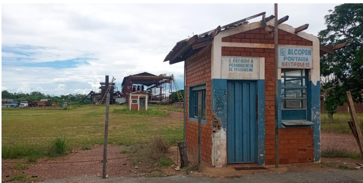
Figura 1: Prédio desativado da ALCOPAN.
