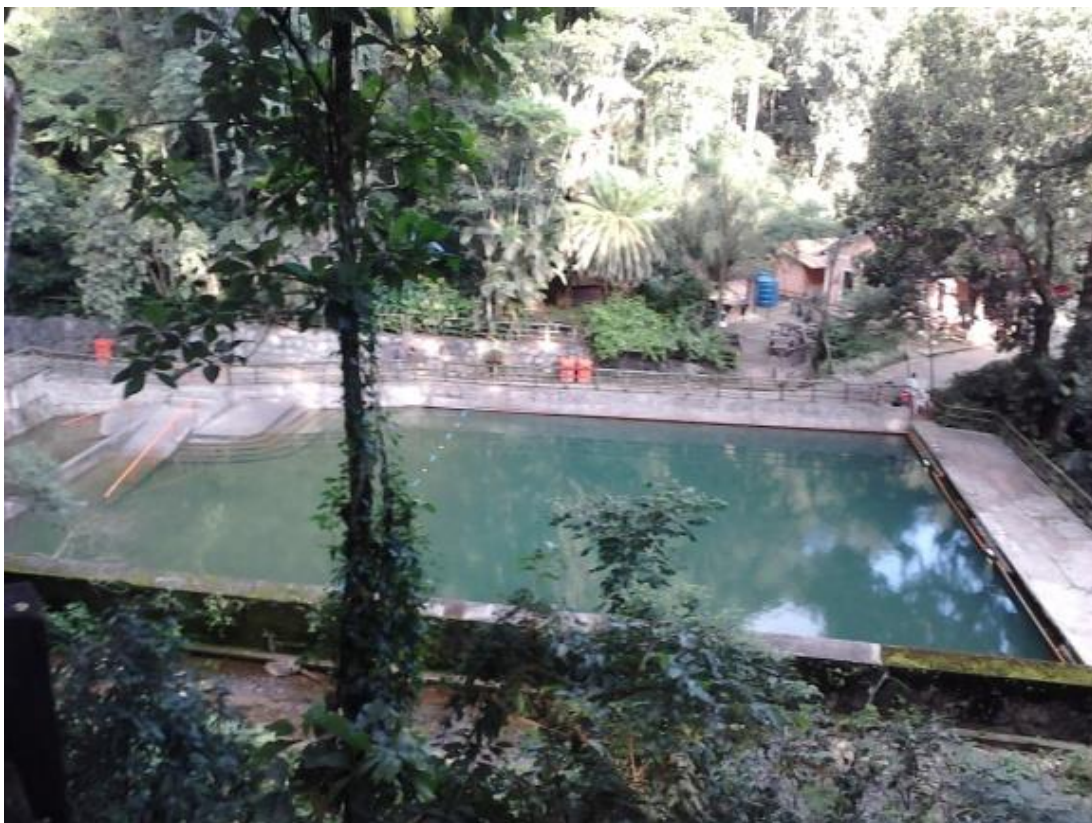
Figura 3. Antiga Caixa D'Água da Fábrica de Tecidos Bangu agora utilizada como piscina, área de Lazer para os visitantes. Arquivo dos autores, 2011
